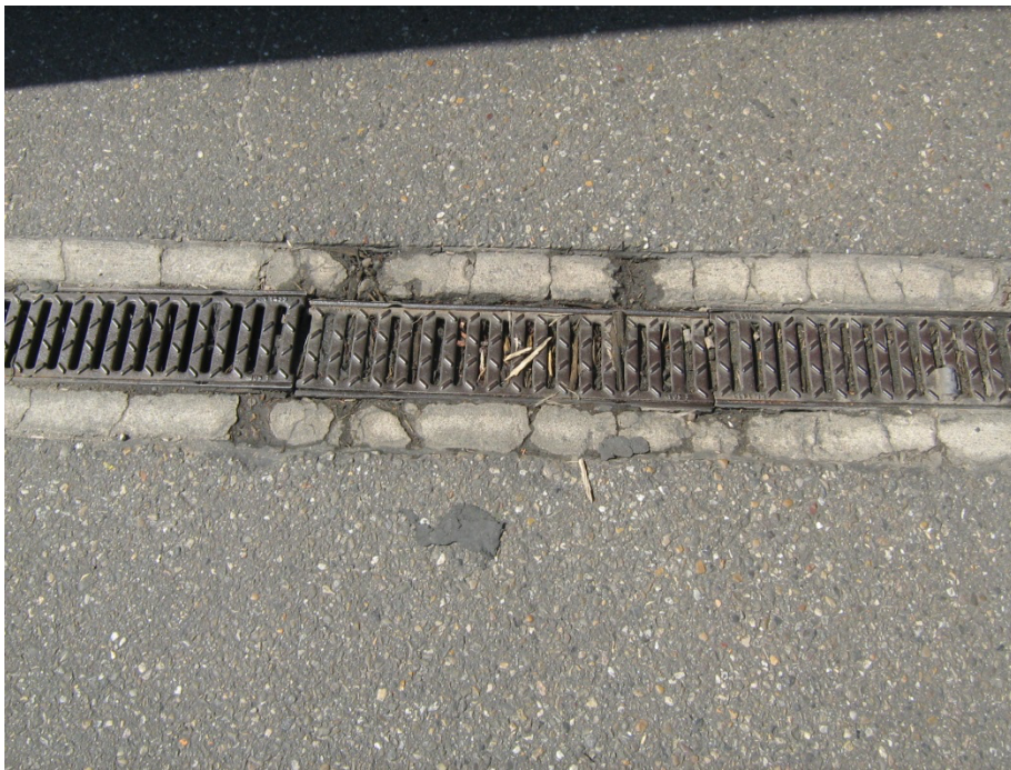
Foto: Aansluiting op lijngoot.
